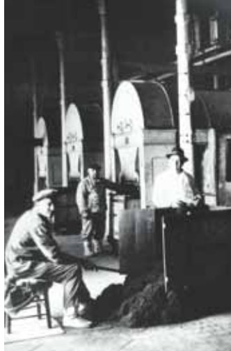
Atelier de torréfaction au rez-de-chaussée du bâtiment D © Centre d'Histoire du travail collection Faucher
