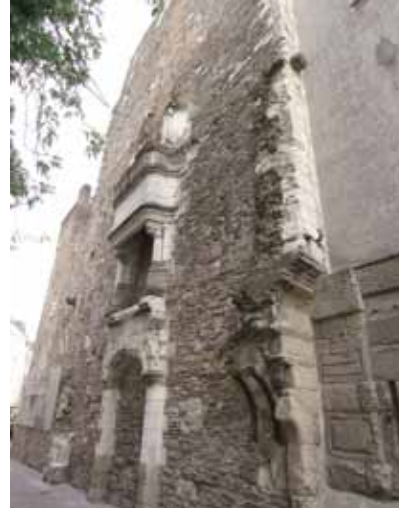
Le « mur des Échevins », vestige encore visible de la maison des Engins
