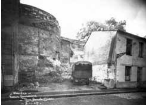
Une des tours de l'enceinte en 1947
