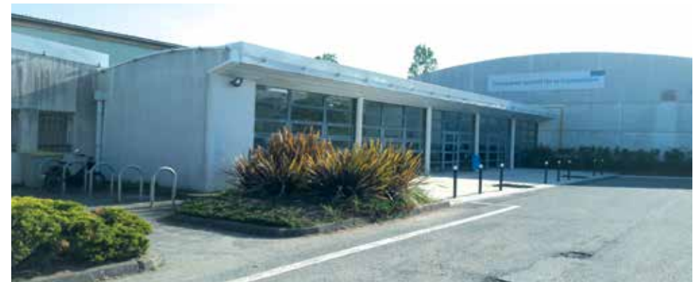
Bande de guidage (gymnase de la Durantière)
