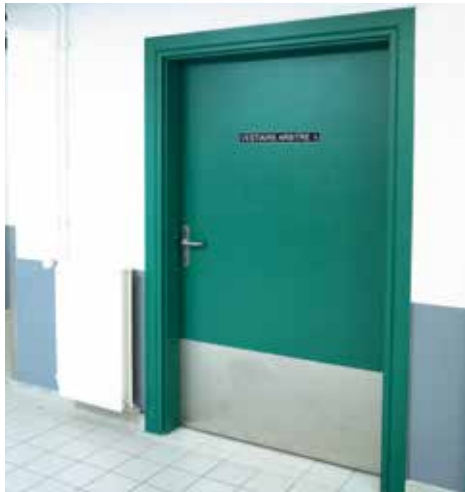
Repérage des vestiaires et sanitaires par leurs portes peintes en vert (gymnase de Doulon)
