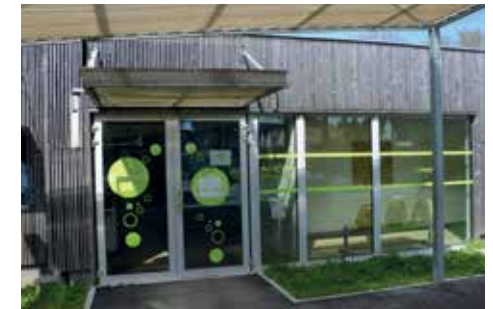
Vitrophanie sur les parois vitrées de chaque zone
