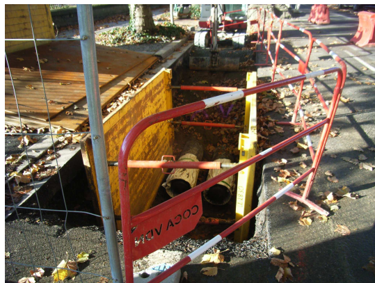
Réalisation d'une tranchée
