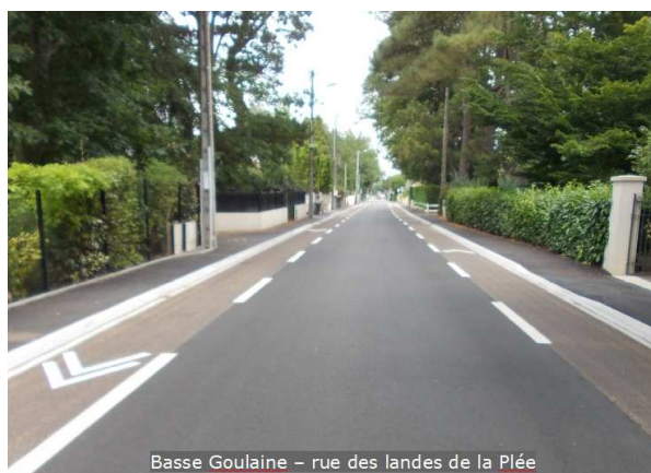
Basse Goulaine – rue des landes de la Plée Bonne perception de l'aménagement par le contraste des matériaux
