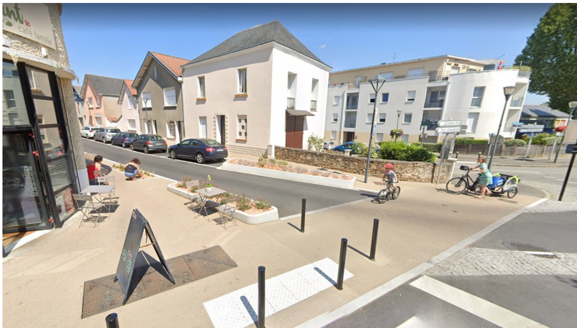
Zone 30 aménagée en 2018 – Rue Charles Laisant (Indre)
