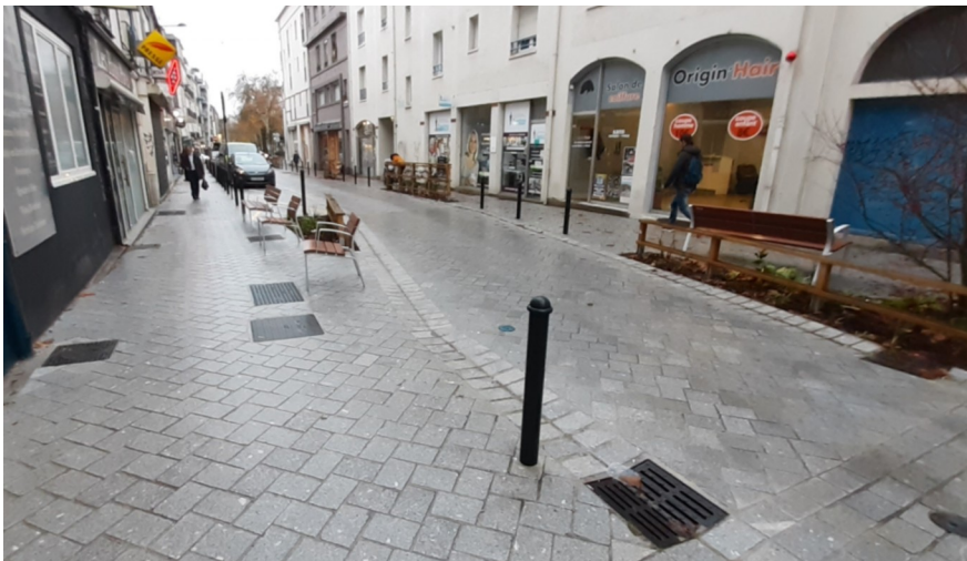
Rue des Hauts Pavés – Nantes
