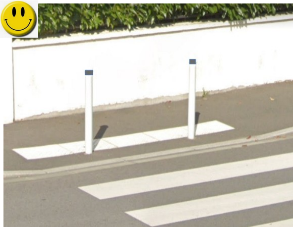
Rue de la Cadoire, Rezé Niveau du trottoir descendu – Nécessite l'autorisation du riverain et de refaire le crépi. Une autre solution peut être un chanfrein sur 20 cm de large environ ou un coffrage pour cacher les fondations.
