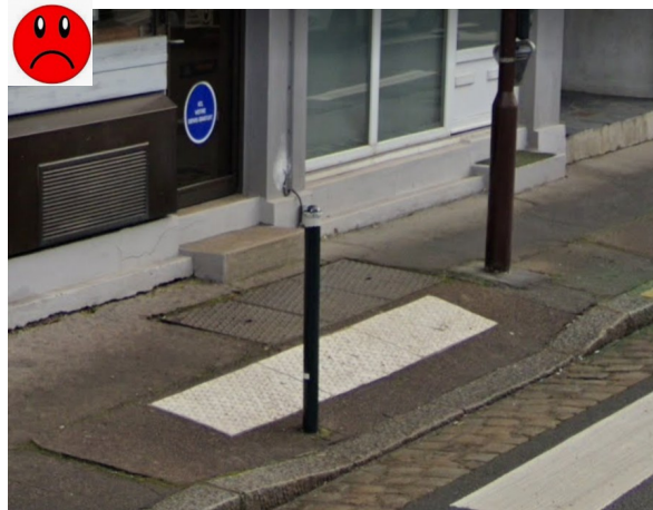
Ici, la pente est abrupte au niveau de la BEV, les rampants sont beaucoup trop courts
