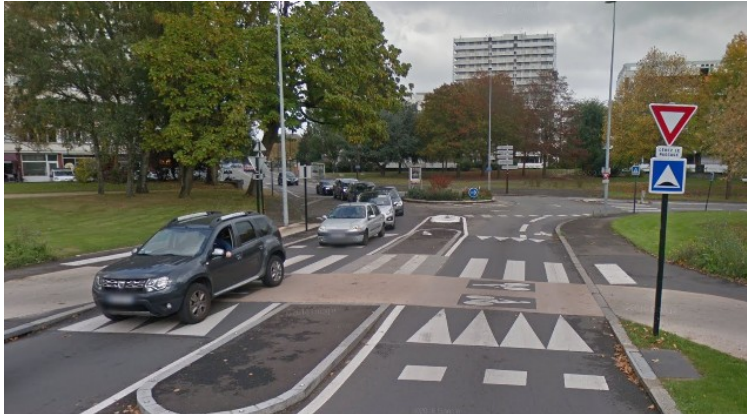
Traversée de chaussée sur la rue Monzie à Nantes
