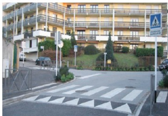
Le plateau traversant offre un cheminement à niveau et oblige les véhicules à modérer leur vitesse
