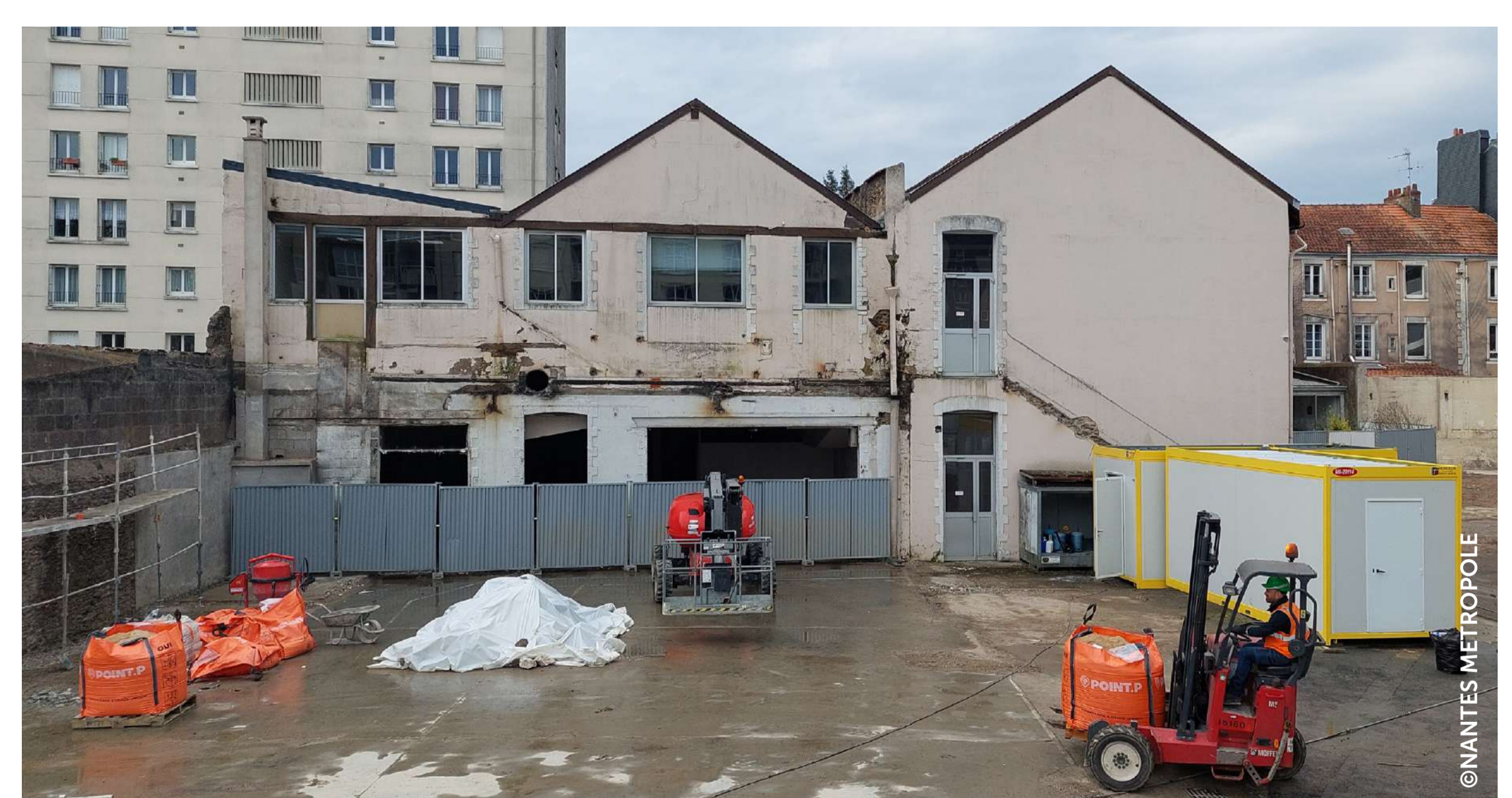
2022 : démolition des entrepôts existants en coeur d'îlot pour faciliter le chantier du BSR
